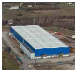
CIMOLAI SpA - Artugna - Italia Area totale 85.000 mq Area coperta 12.000 mq
