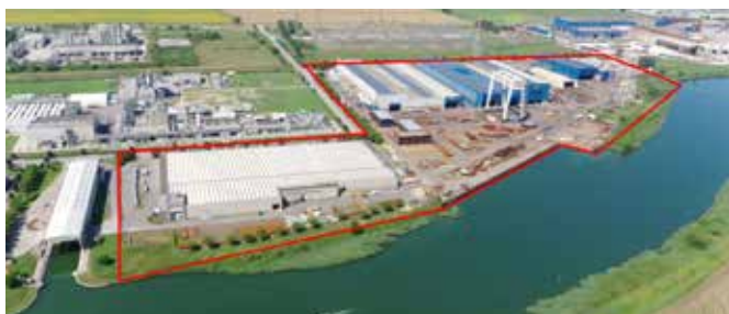
CIMOLAI SpA - S. Giorgio di Nogaro - Italia Area totale 180.000 mq - Area coperta 60.000 mq
