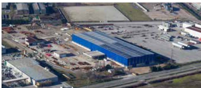
CIMOLAI SpA - S. Giorgio di Nogaro 2 - Italia Area totale 95.000 mq - Area coperta 12.000 mq
